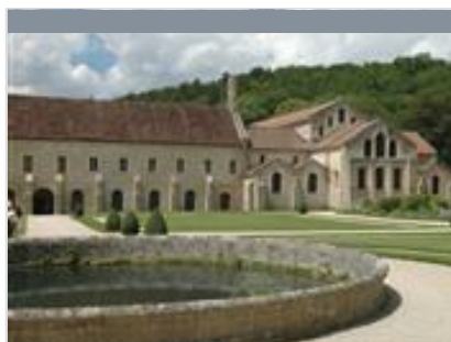
Boucle locale en espace partagé : Abbaye de Fontenay
